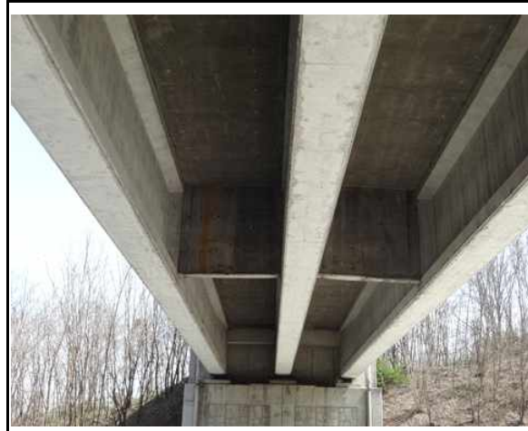
바닥판하면 및 거더 전경
